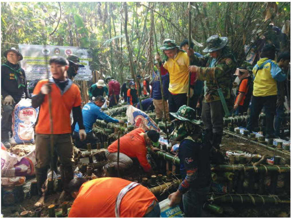
ภาพบรรยากาศการก่อสร้างฝายมีชีวิต
